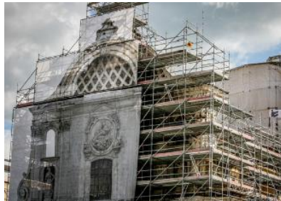
L'Aquila, chiesa delle Anime Sante in restauro dopo il sisma
